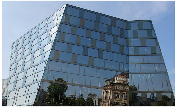
Abb. 8. Fassade der Universitätsbibliothek Freiburg (Foto: UB Freiburg).
